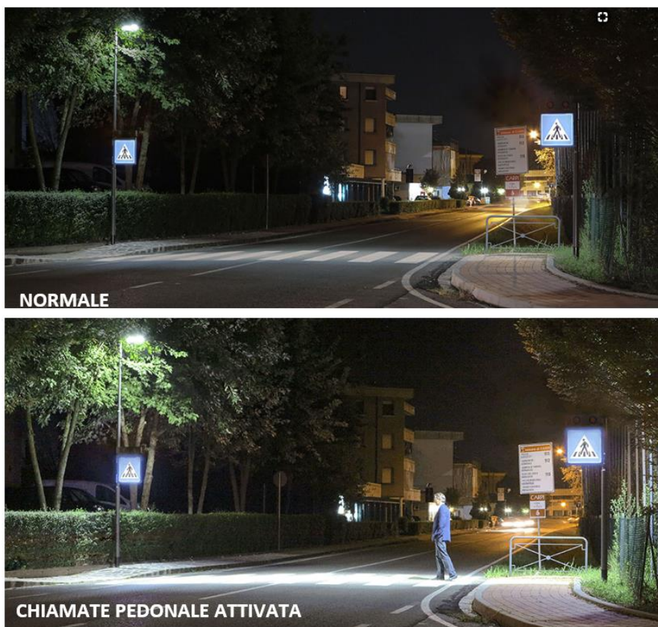
Figura 8 Esempio di illuminazione dedicata di tipo smart per passaggio pedonale
